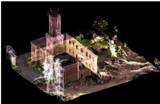
Рис. 9 розробка 3-D моделі відновлення пошкодженої будівлі методом лазерного сканування
