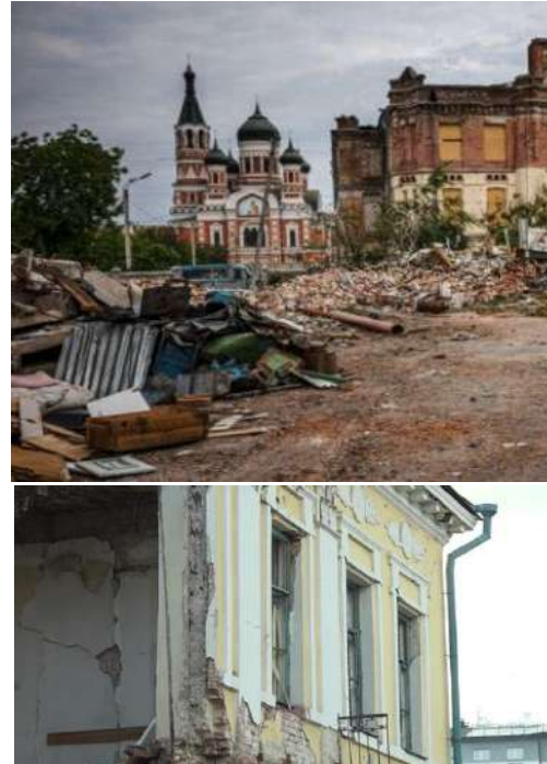
Рис.3. Руйнування історичної будівлі внаслідок війни в центрі м. Харків
